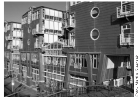
Das am Hafen liegende Verlagsgebäude erinnert an ein Schiff.
